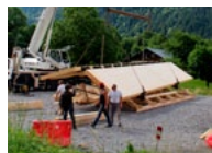
Aire de lavage p. 42
