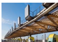
Reconstruction des auvents de péage p. 30
