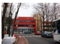
Réhabilitation énergétique des bureaux de la CNAV p. 192
