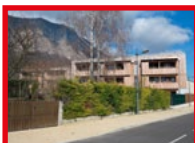
Construction de logements locatifs sociaux à Crolles p. 80
