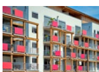
Construction d'un éco- immeuble de 38 logements p. 102
