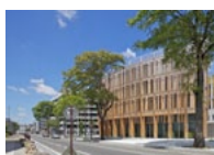
Bâtiment B Pôle Bois p. 36
