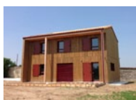
Construction d'une maison individuelle bois BBC p. 233
