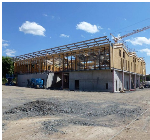
La bâtiment en chantier.
