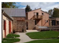
Maison bioclimatique à Saint Goustan p. 230
