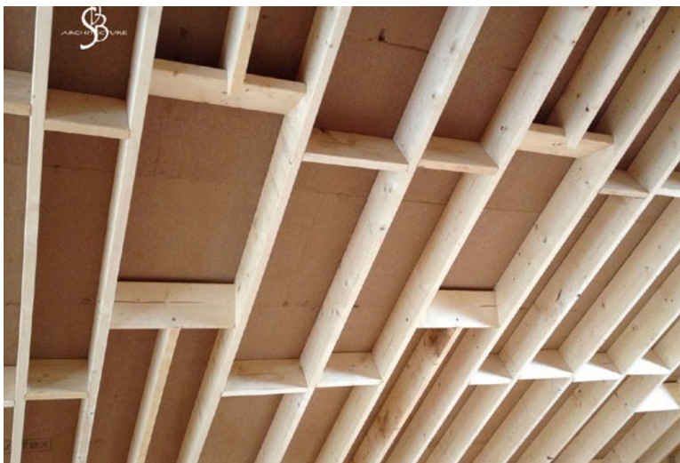
Caissons de toiture.
