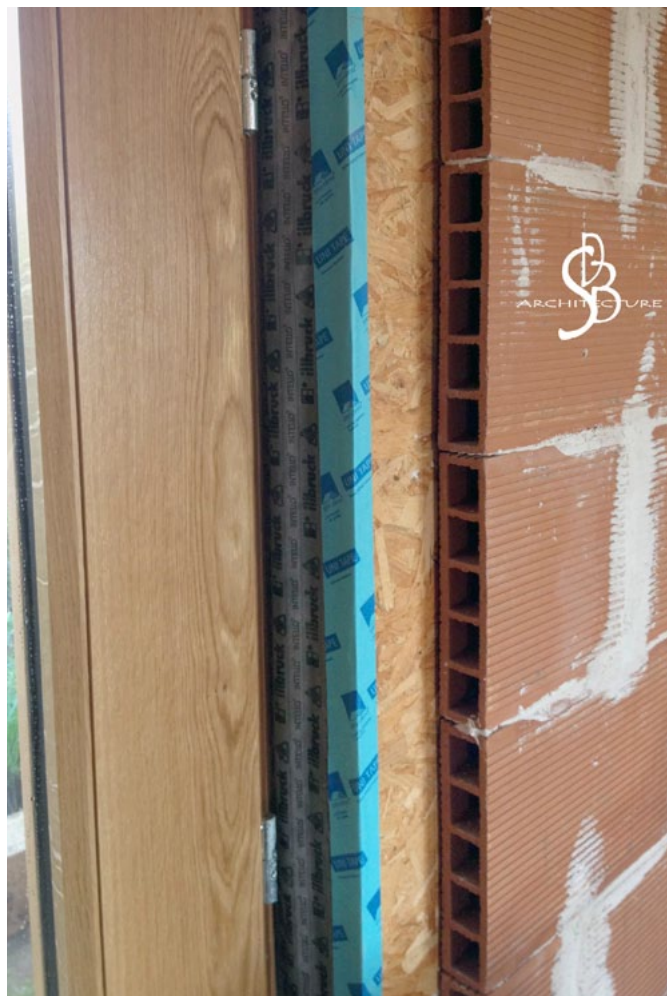
Détail intérieur fenêtre.
