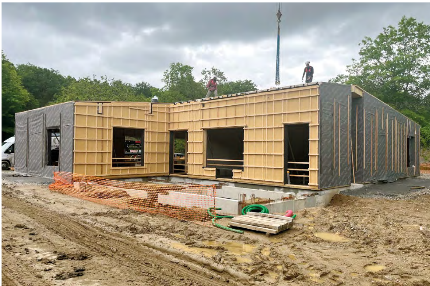
Chantier en cours d'un centre d'hébergement qui comprendra 5 bâtiments publics isolés en paille hachée. Maître d'ouvrage : Ville de Limoges.
