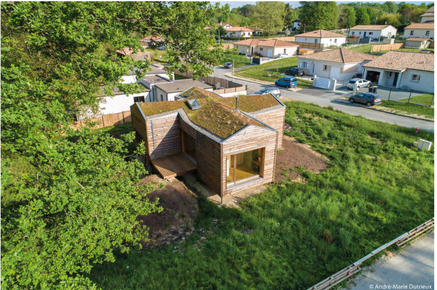
Crédit photo : © Drone-view
