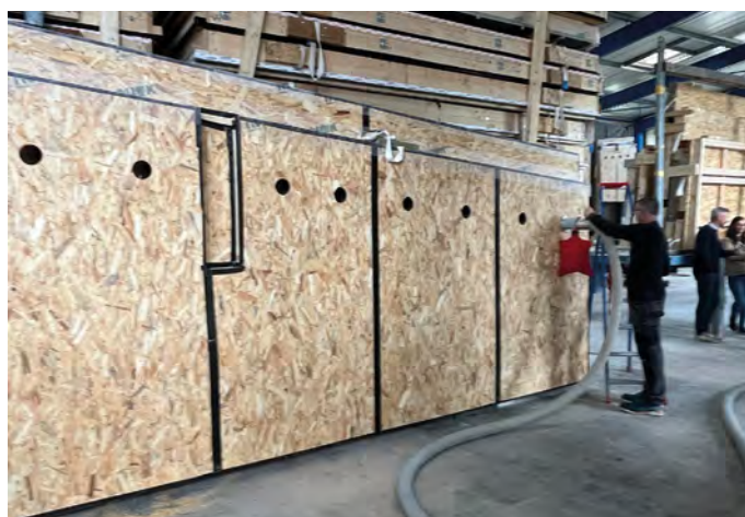
Insufflation de la paille dans le mur ossature bois
