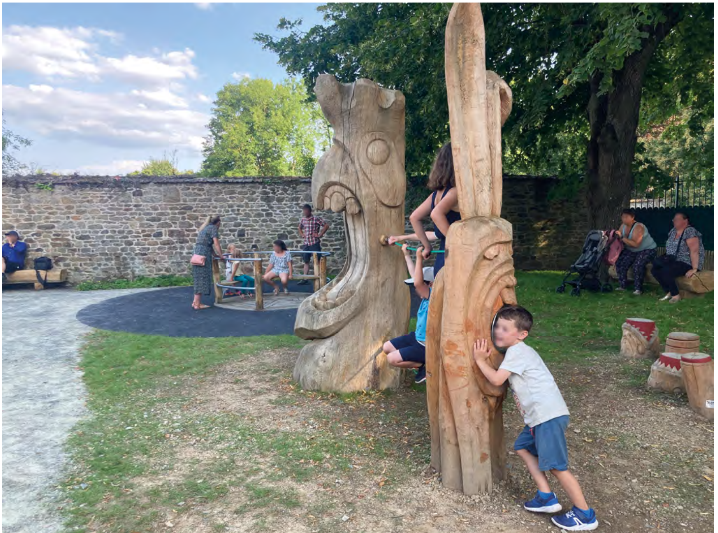
Le squelette de la créature a été conçu comme une membrure de bateau en acacia, puis bardé en bois de chêne et rempli de la terre décaissée lors du terrassement - © Paquito Couet
