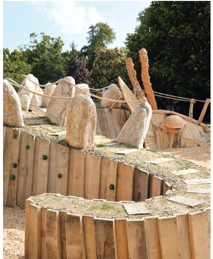
Le squelette de la créature a été conçu comme une membrure de bateau en acacia, puis bardé en bois de chêne et rempli de la terre décaissée lors du terrassement - © Paquito Couet
